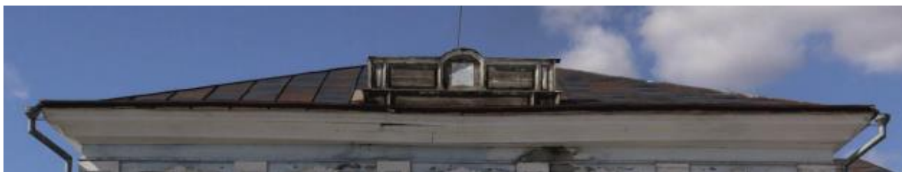
Венчающий карниз второго этажа и парапет.
