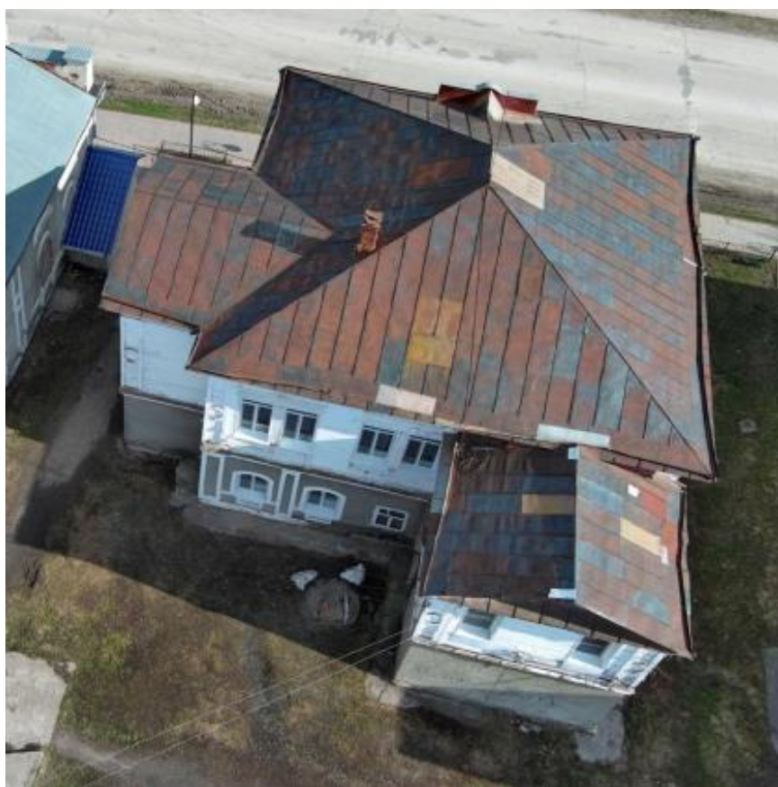
Вид крыши сверху со стороны северо-западного фасада.
