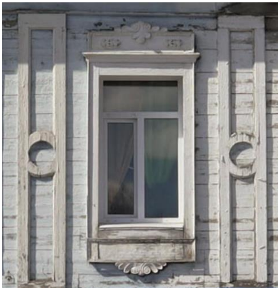
Лопатки и наличник оконных проёмов второго фасадов второго этажа.
