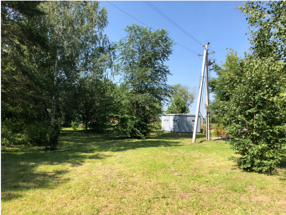
Неорганизованные пешеходные транзитные пути, не имеющие твердого покрытия и освещения
