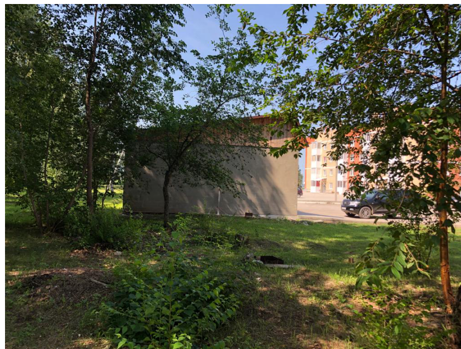
Отсутствие элементов ограждения между парковочными местами и пешеходной дорогой
