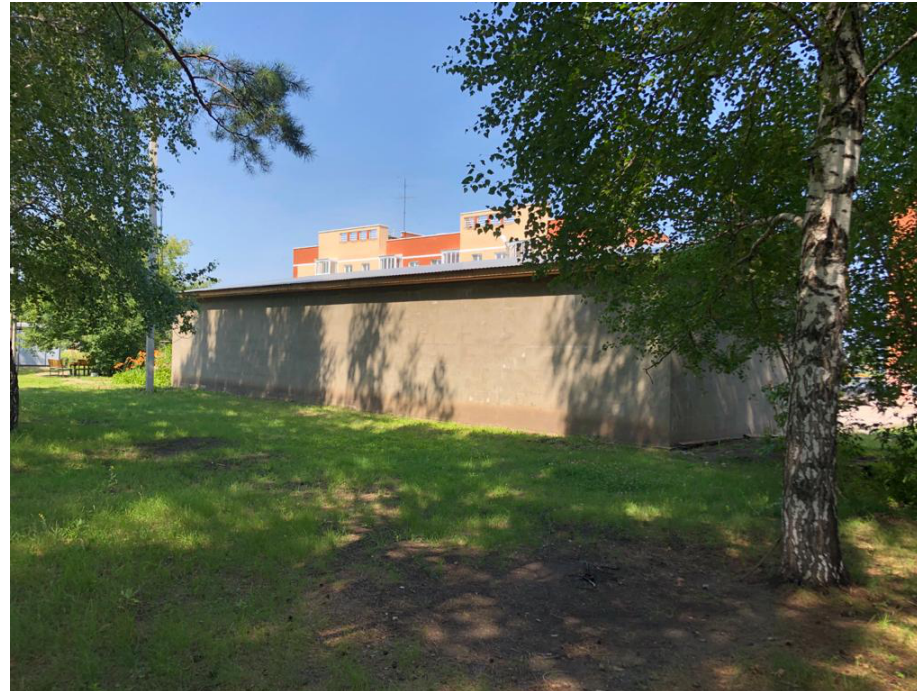
Отсутствие фасадного решения прилегающих сооружений
