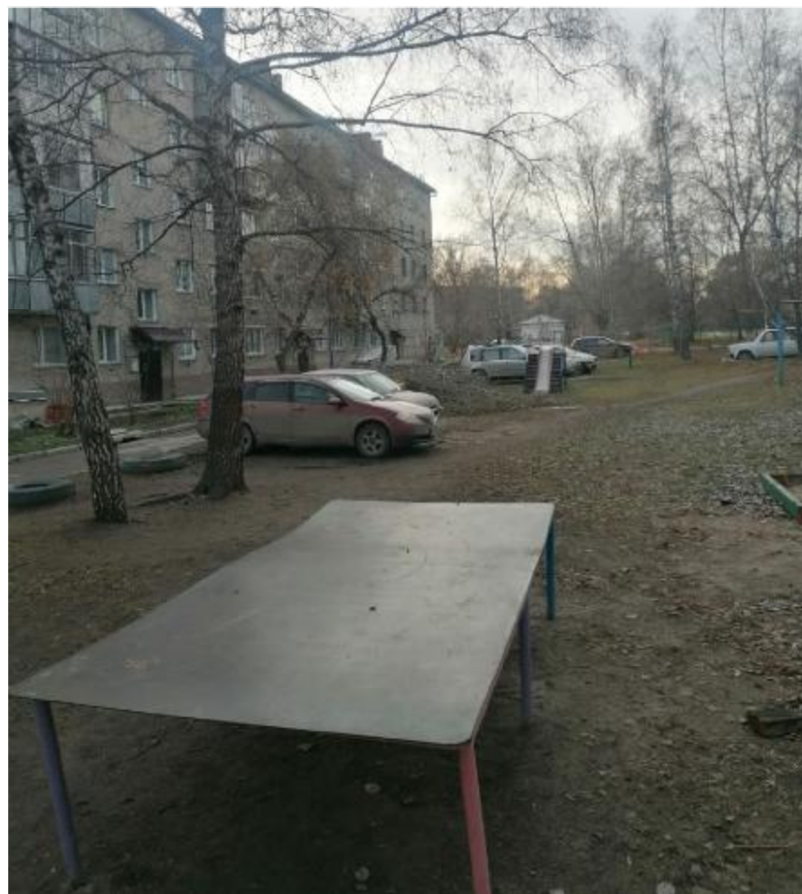
Устаревший детский игровой комплекс (облупилась краска, имеются острые углы в местах сварки элементов)
