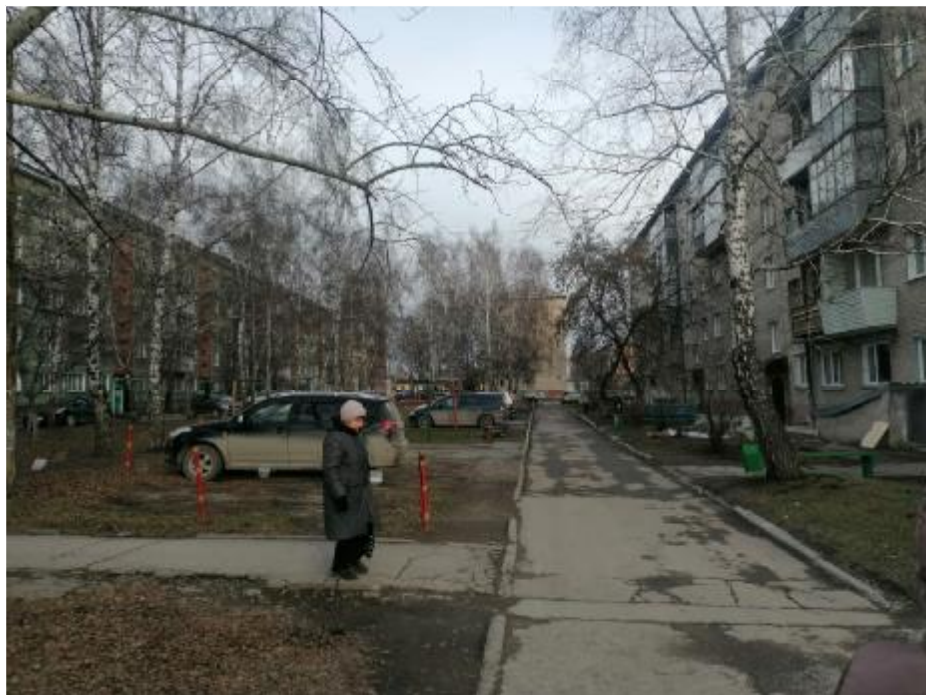
Из-за не хватки парковочных мест, газон используется не по назначению, газонное покрытие разрушено
