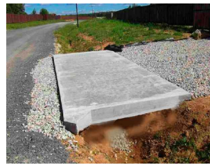
Устройство перехода через кювет с ограждением
